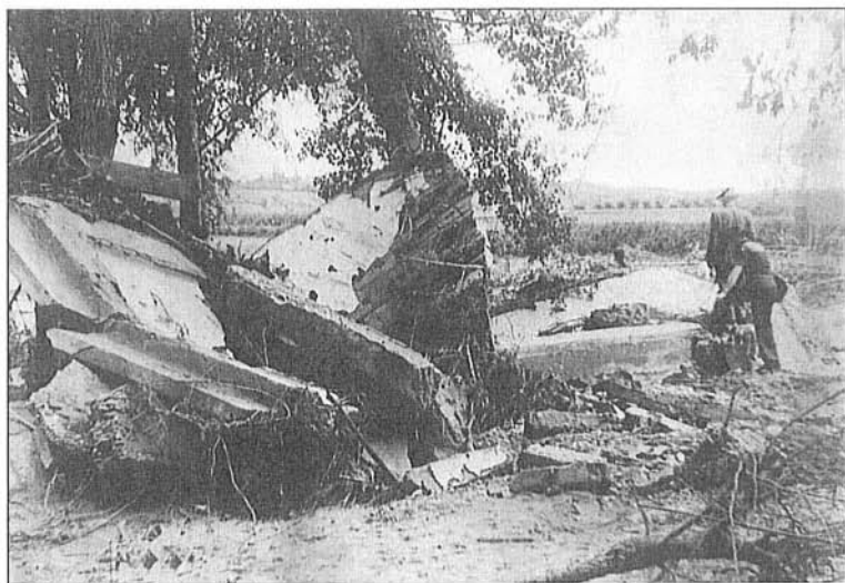
Il ponte crollato
